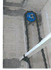
刮泥軸固定座(尾端處)
