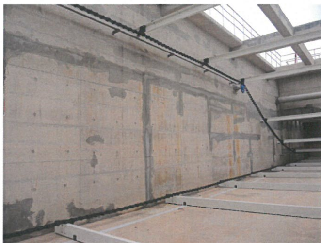
上部角軸鏈輪(惰輪)後鏈條重力自然下垂
